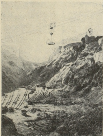
A Murrum bidgee legfelső szakadásán épülő kőgát.
