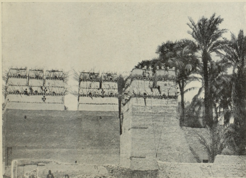
EGYIPTOM, ASSZUAN. KÖCSÖGÖKBŐL ÉPÍTETT GALAMBTENYÉSZTŐ HÁZ.
