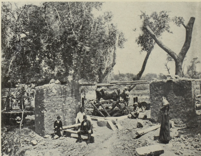
EGYIPTOM. SZAKIJE, JÁRGÁNNYAL HAJTOTT, VÖDRÖS VÍZEMELŐ KERÉK KÚT FÖLÖTT.
