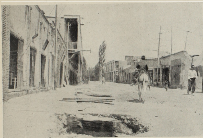
Sáhrúd. Az épülő város.
