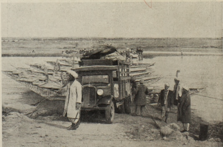
Girisk. Átkelés a Helmenden. Balra az épülő híd pillérei.
