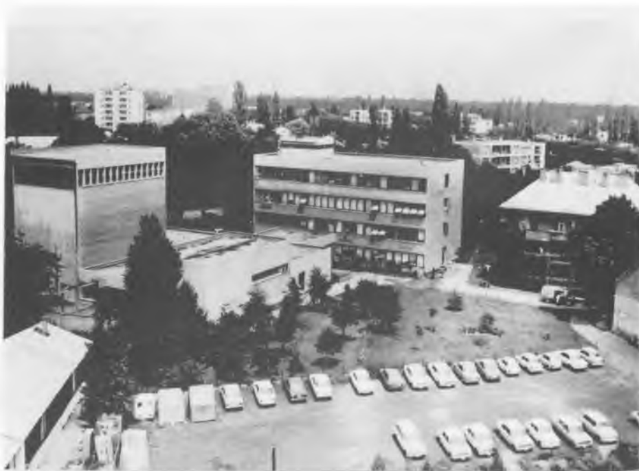
A IV., VIII. és IX. épületek. A ciklotron épület helyén még gépkocsi parkoló van (1981).
