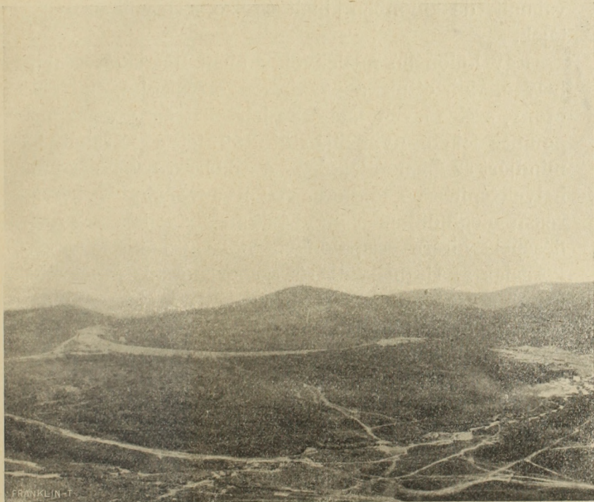
A vasútépítés kezdete.
