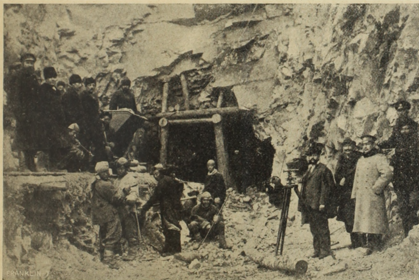
Az alagútépítés kezdetén.
