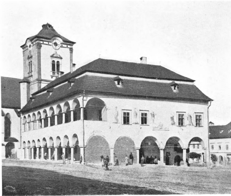
55. A lőcsei városháza restaurálása előtt.
