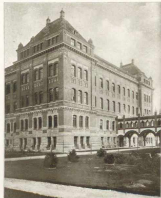
Központi épület nyugati szárny
