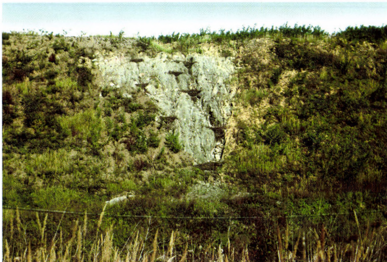
24. kép. A rézsűkön később kialakult vízmosások megkötése rőzsegáttakkal
