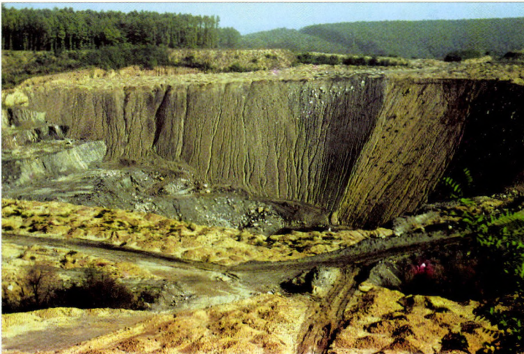
22. kép. A „termőtalaj” (löss) elterítése a felszínre
