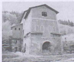
2. ábra A Károly-kohó, épült 1843-ban, ma műemlék
