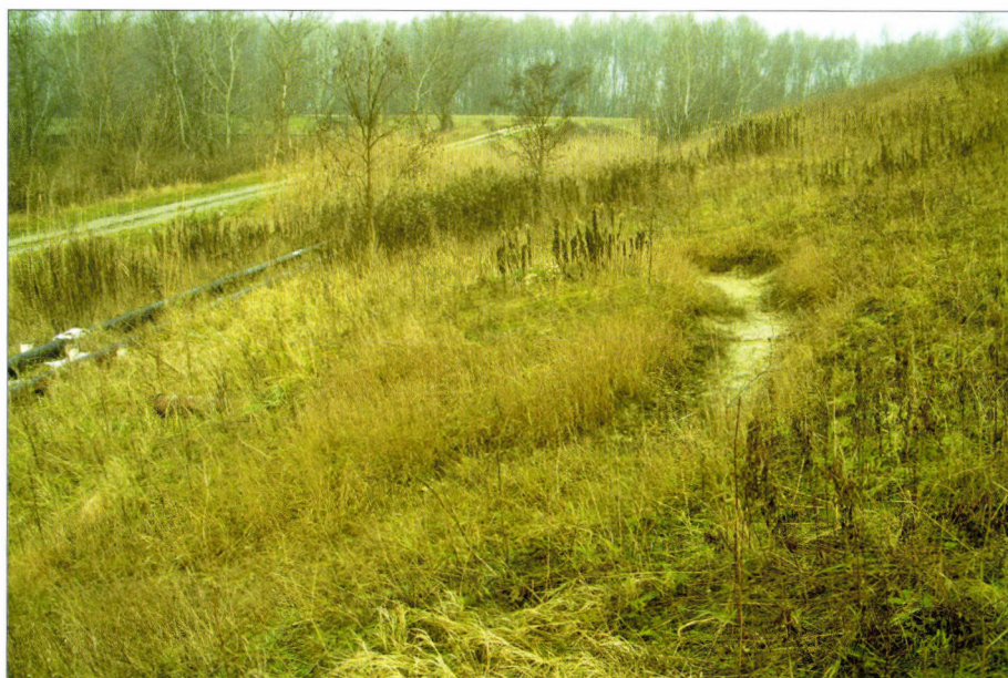
28. kép. Szakadáskaréj és csuszamláshalmaz az almásfüzitői VII. sz. vörösiszap-tározó gátján. Fotó: VICZIÁN I. 2000.
