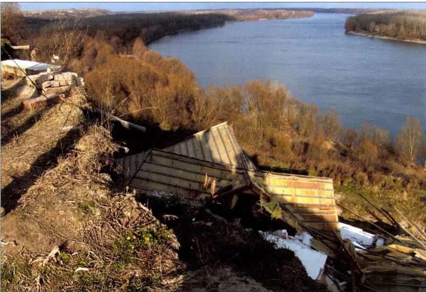
50. kép. A partfal 2008 februárjában leomlott része. A jól megfigyelhető, hogy a Duna sodrása alámosza a magaspartszakaszt, amely előidéz a földcsuszamlásos folyamatokat. Fotó: SCHWEITZER F. 2008.
