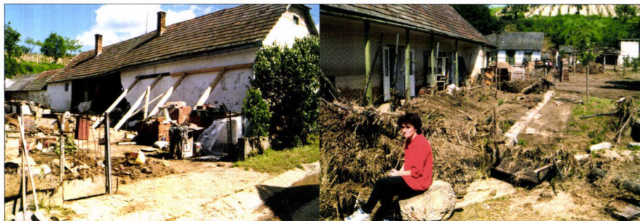
64. kép. A Bársony utca Nagykönyiban a villámárvíz másnapján. A ház nem bírta a kb. 1 m magas víz nyomását, és hátsó fala kidőlt. Az épületet (balra a hátsó fal, jobbra a bejárati oldal) később lebontották. Fotó: FÁBIÁN Sz.Á.
