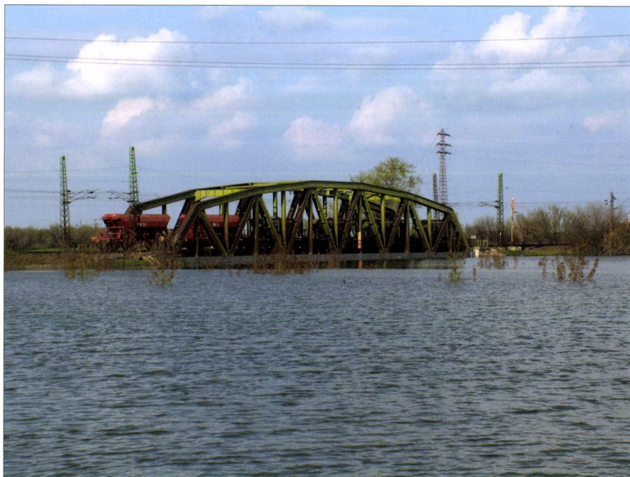
1. kép. A szolnoki vasúti híd a Zagyva felett 2000 áprilisában. A hidat kavicsokkal telerakott vagonokkal stabilizálják. Fotó: KÖTIVIZIG
