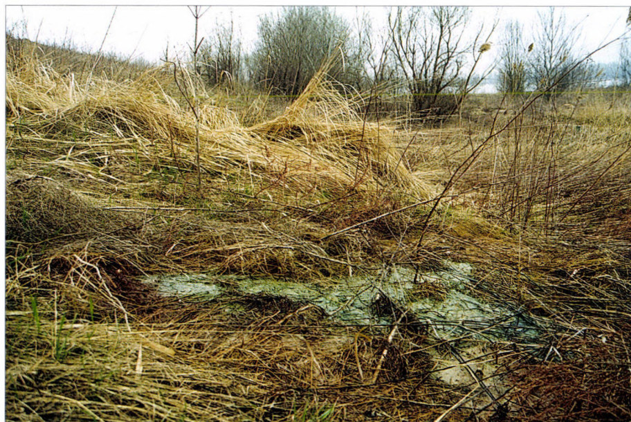
29. kép. Az almásfüzitői VII. sz. kazetta gátjának részűjén fakadó forrás. Fotó: SCHWEITZER F. 2000.
