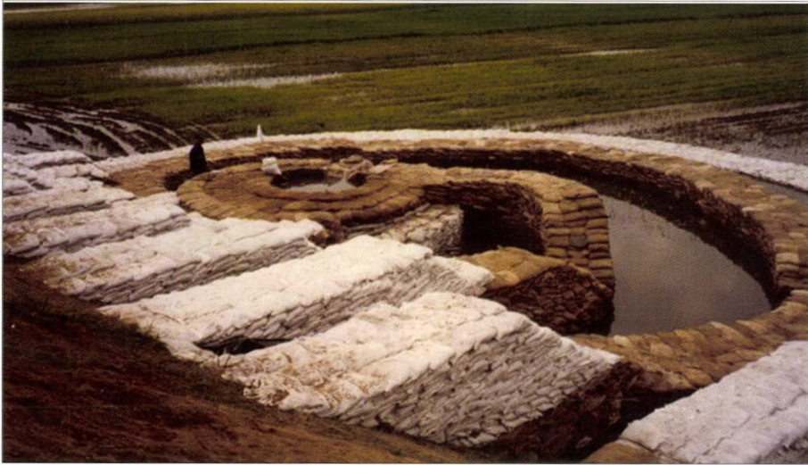
13. kép. Közép-Európa legnagyobb buzgárja Tiszasasnál 2000 áprilisában. A buzgár a Tisza bal partján a mentett oldalon, a töltés lábától 4 m-re alakult ki. Fotó: KÖTIVIZIG
