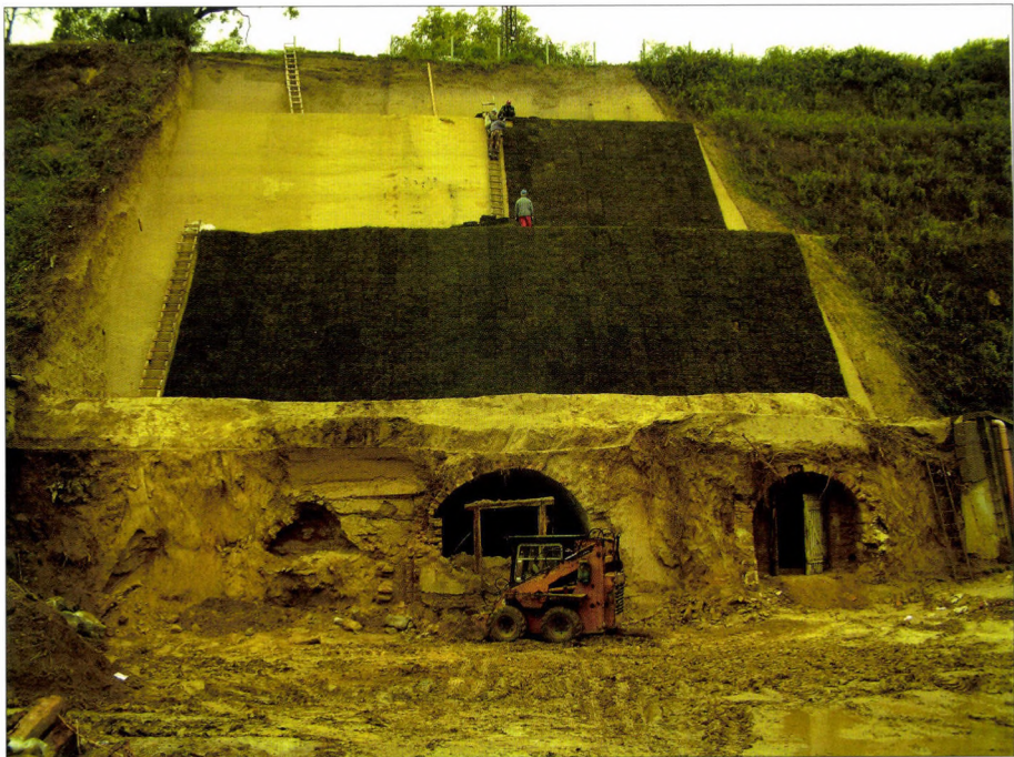
47. kép. Partfal rehabilitáció Dunakömlőd belterületén. Fotó: BALOGH J. 2003.
