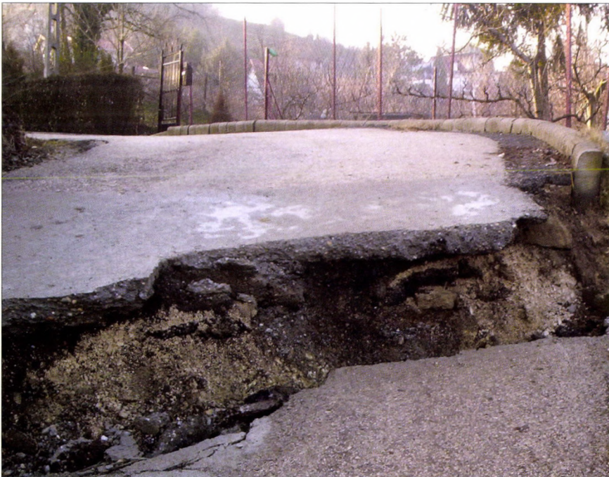
40. kép. 2011. január 17-én földtömegmozgások következtében megrongálódott út Kulcson a dunai magasparton. Fotó: BALOGH J. 2011.
