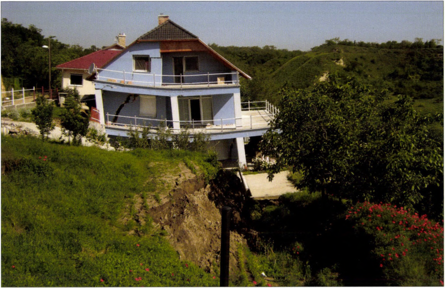
69. kép. Csuszamlás következtében keletkezett épületkár Százhalombattán.
