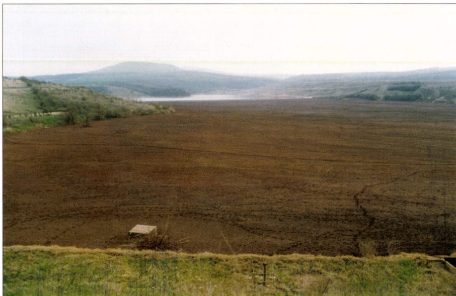
34. kép. A neszmélyi vörösiszap-tározó, háttérben az ülepítőt a völgyzáró gátról fényképezve. Bal oldalon a csuszamlásveszélyes völgyoldal, amelyet később lépcsőzetesre alakítottak ki. Fotó: SCHWEITZER F. 2000.
