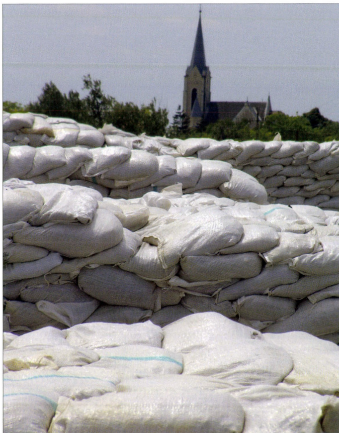
12. kép. Rézsűcsúszás és buzgár elleni védekezés 2006-ban a Hármas-Körös árvédelmi töltésén Szelevénynél, ahol a lakosságot kitelepítették és a község csak "Isten kegyelmének" köszönhetően menekült meg az elöntéstől. Fotó: SCHWEITZER F.
