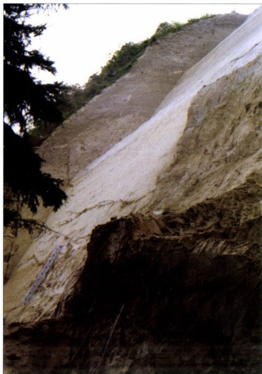
45. kép. A dunaföldvári Vár-domb 2000. évi földtömeg-mozgásának helyszíne, a szakadás frontja és a megkezdett partfal helyreállítási munkák eredményei. Fotó: SCHWEITZER F. 2000.
