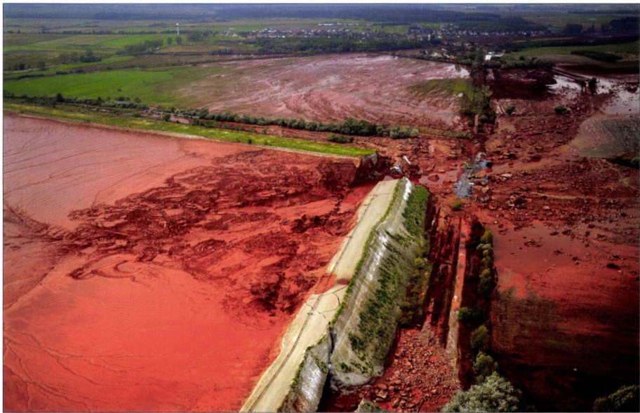
25. kép. A X. sz. kazetta sérült gátja és a vörösiszappal elöntött területek. Fotó: H. SZABÓ S., MTI
