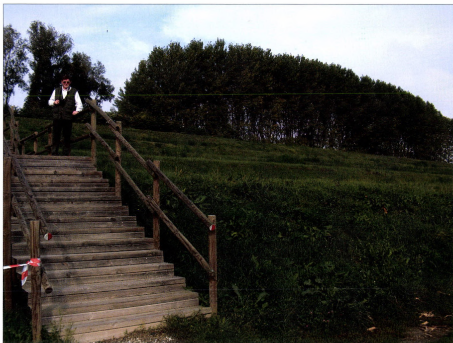
10. kép. Erőteljes mederfeltöltődés következtében a Pó többször (5–7 alkalommal) megemelt árvízvédelmi töltése Ferraránál. Fotó: BALOGH J.
