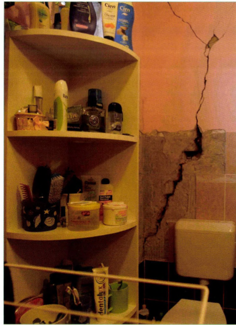
68. kép. A 2011. január 29-i oroszlányi földrengés ( M = 4,5 , I_0 VI) során megsérült lakóház Vértessomlón. Fotó: Túry G. 2011.
