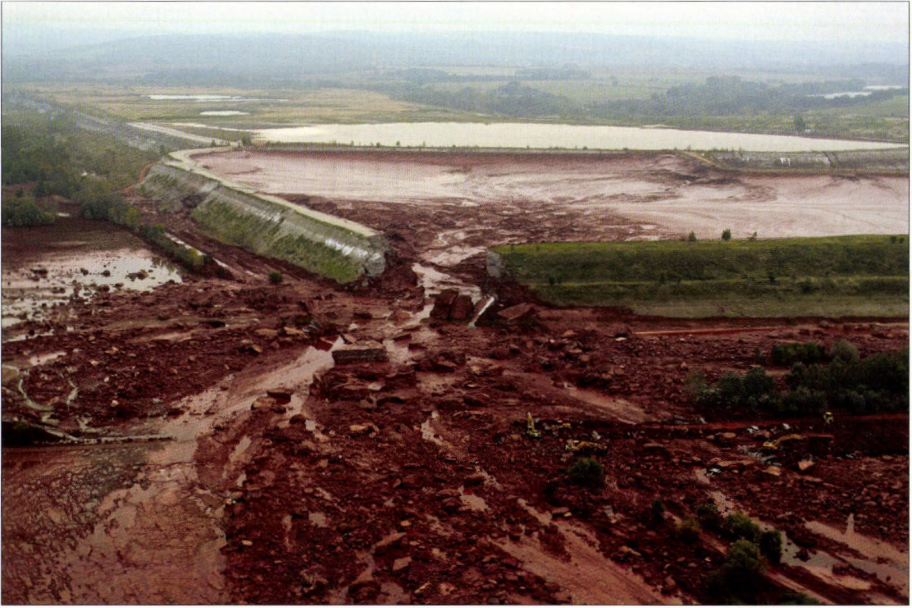
24. kép. Az ajkai vörösiszap-tározók és a X. sz. kazetta sérült gátja. Fotó: VARGA Gy., MTI
