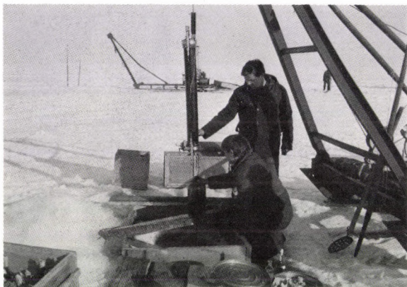
7. A fotoelektron-sokszorozó leengedése a léken át.
