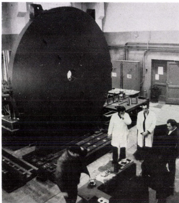
3. A neutrínódetektor műonspektrométer részének egy mágneses korongja.
