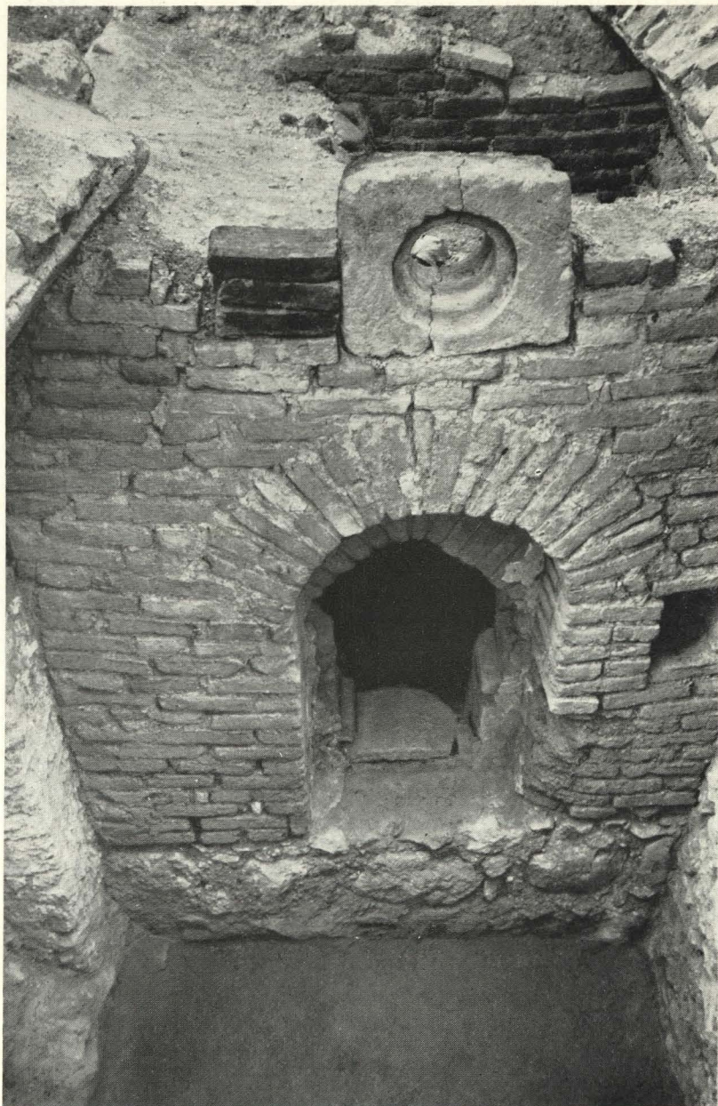
16. Az iskola fűtőberendezésének kemencéje
