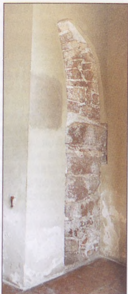
Román kori ív az előcsarnok D-i sarkán – Romanischer Bogen an der Ecke der südlichen Vorhalle
