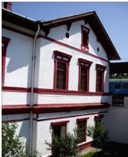
105. kép. Oravica állomás. Jobb oldali homlokzat 2008-ban
