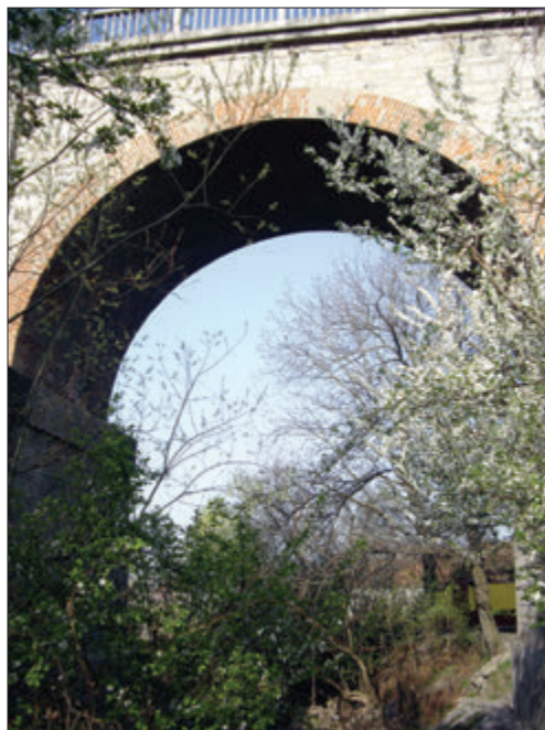
93. kép. Az oravicai viadukt jobb oldali, utolsó íve 2012 áprilisában
