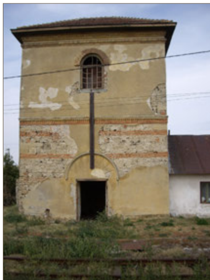
124. kép. Rakasdia állomás. A víztorony vasút felőli homlokzata a vízmérce fémsínjével
