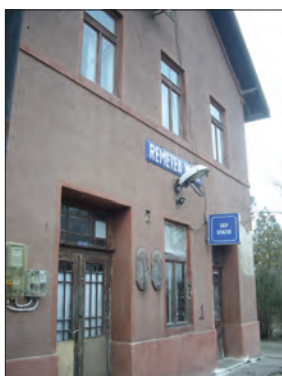
133. kép Máslak-Remete állomás felvételi épülete a vasút felől 2018. február 25-én. A falon még látható a harangjelzők helye
