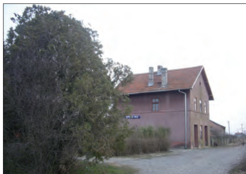
131. kép Máslak-Remete állomás út felőli homlokzata
