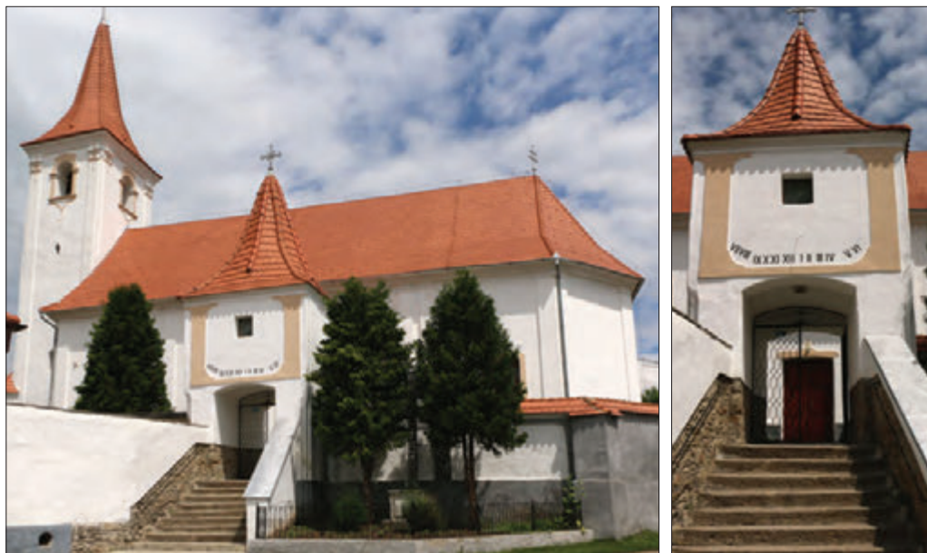
332. kép. Kászonújfalu, római katolikus templom (1796), f: 2016
