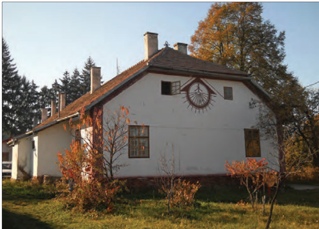
18. kép. Felsőszombatfalva, a régi apátsági épület, f: 2015
