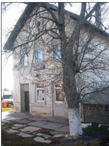
86. kép Kenézfalva állomás a vasút felől
