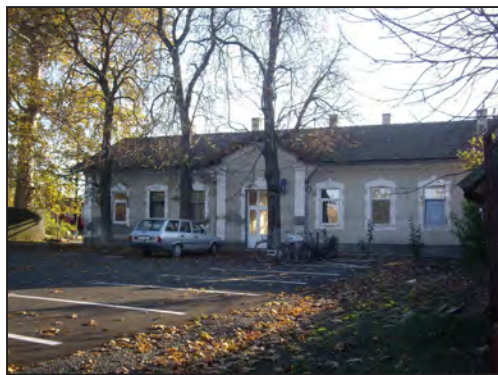
158. kép A perjámosi állomás felvételi épülete az utca felől
