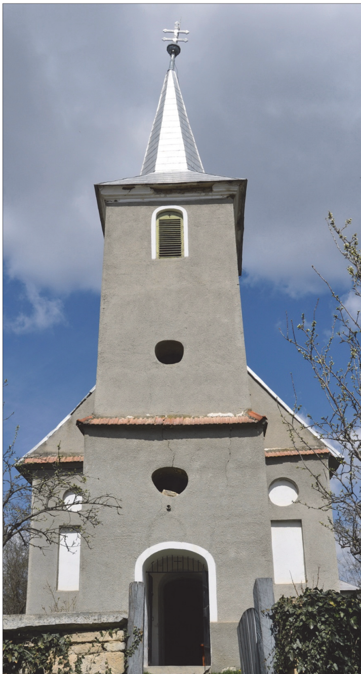
20. ábra A katolikus templom
