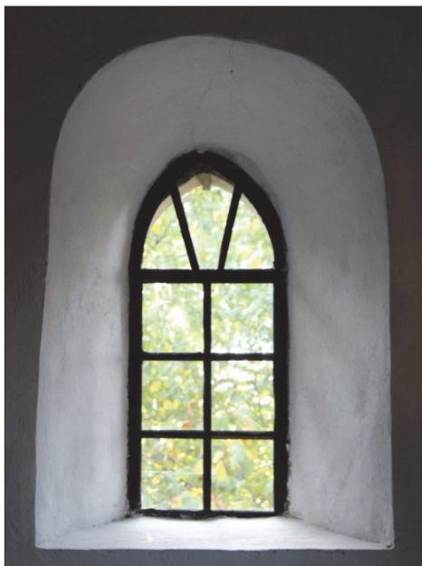
12. ábra A megnagyobbított gótikus ablak
