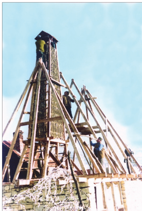
31. ábra Magas, meredek tetőszerkezet építése
