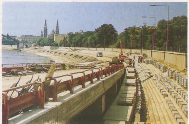
Szegedi árvízvédelmi partfal építés közben
