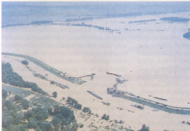
Gátszakadás elzárása a Körösön
