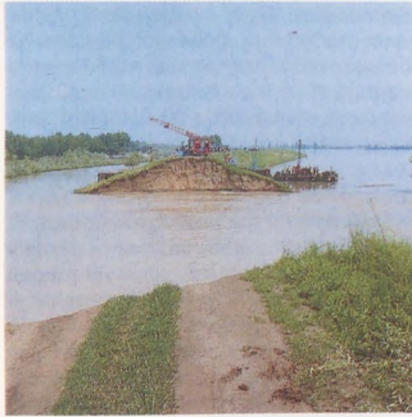
Töltésszakadás a Körösön 1980-ban
