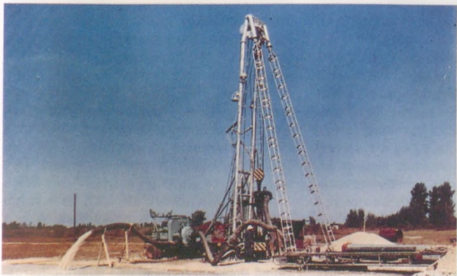
Kútfúró berendezés üzemben (K-6 típusú, 300 m mélységi kapacitású fúrógép munka közben)
