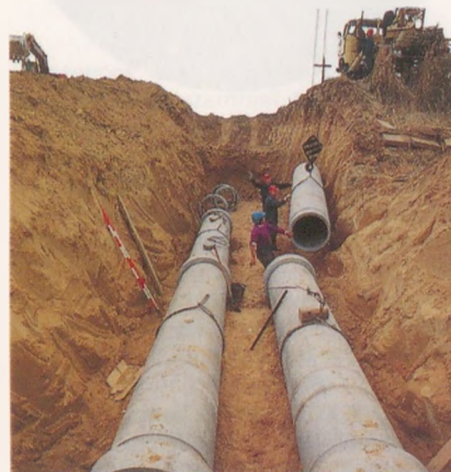
Csatornavezeték-fektetés
