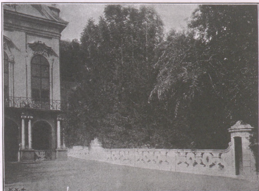
A feljárat kökerítése.
