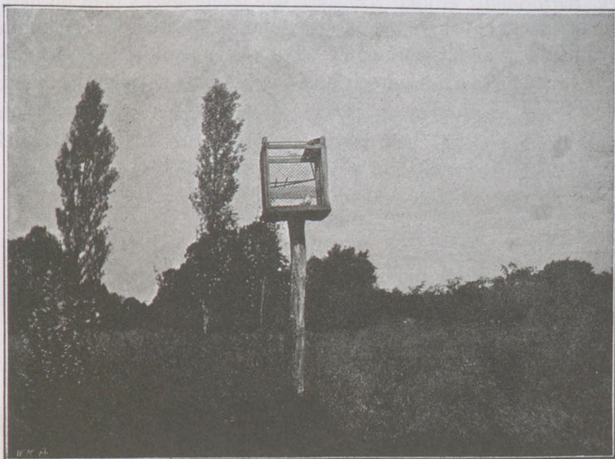
Sasfogó a Fácánkertben.
