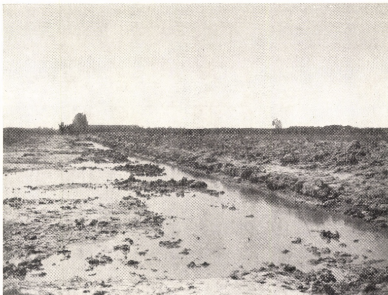
35. ábra. Bulldózerrel összetolt nagybakhát, rendezés előtt. A termőrétegtől megfosztott szegélycsík a vizet nem képes elnyelni. 14 c. (A szerző felv.)
