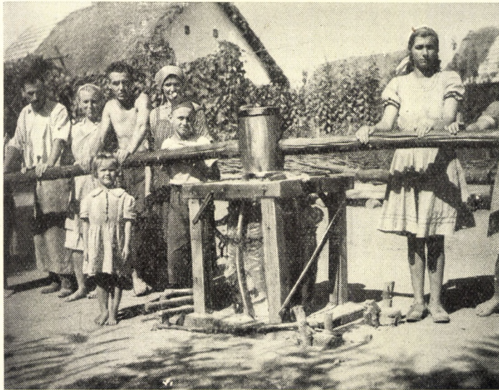
81. ábra. Négyzetes kalodás, forgó bálványos dörzsölő. Méhkerék, Békés m.
