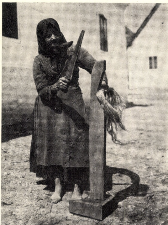
105. ábra. A kender tisztítása csapódeszkán csapókarddal. Szentjakabfa, Veszprém m.
