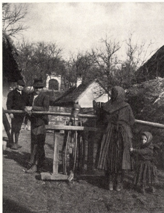
79. ábra. Négyzetes kalodás, rögzített bálványos dörzsölő. Nagyecsed, Szabolcs- Szatmár m.
