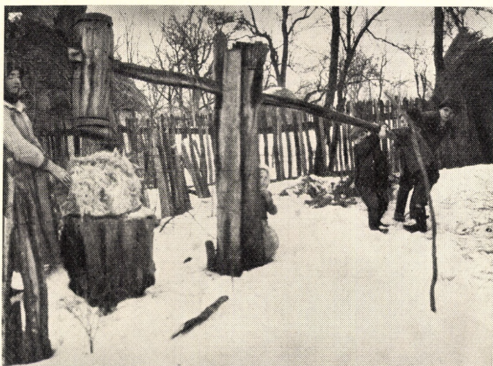
108. ábra. Rostpuhítás kétkarú kenderkalapáccsal. Nyíri, Borsod-Abaúj-Zemplén m.
