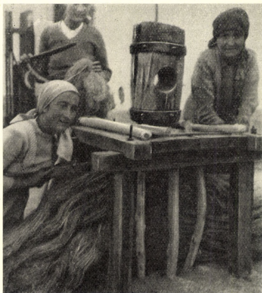
85. ábra. A kenderfejek behúása a kalodás dörzsölő bálványának a nyílásába. Beregsurány, Szabolcs-Szatmár m.
