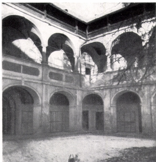
139. Nagybicse — Bytča. Udvari loggiák a stukkók maradványaival
