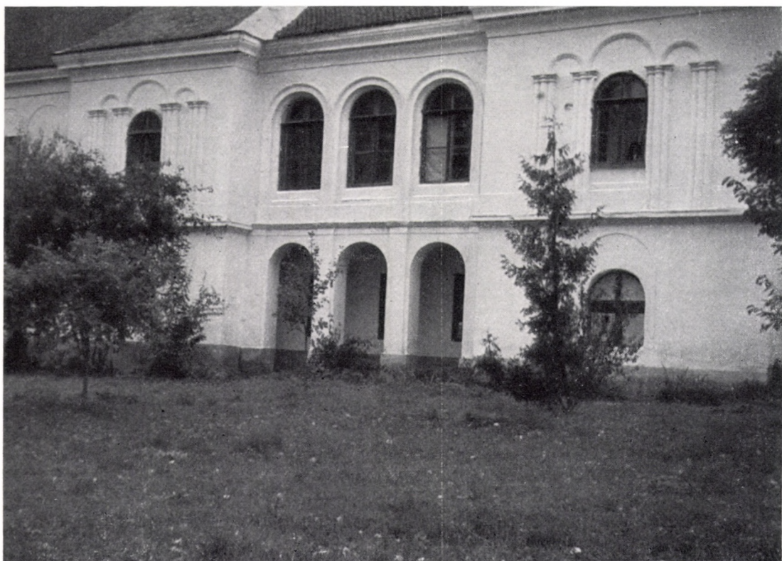
81. Gyalu — Giläu. Részlet a főhomlokzatról az 1877-es átépítésből származó díszekkel
