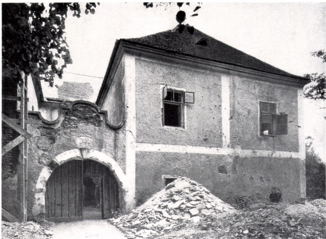
42. Bozsok. Volt Sibrik-kastély. A kapu (helyreállítás alatt)
