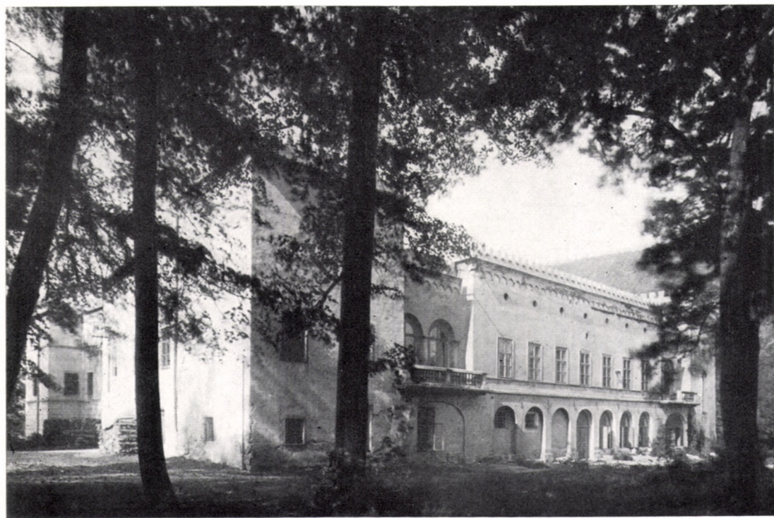
198. Zólyomradvány — Radvaň. A kastély átalakított hosszanti homlokzata
