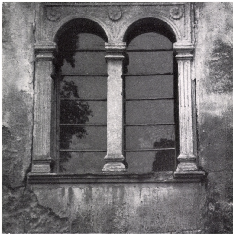
13. Alvinc — Vințu de Jos. Ikerablak és timpanonos ablak az udvari homlokzaton
