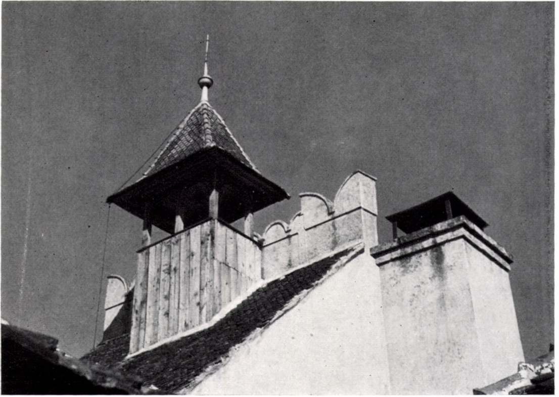
191. Törösvár — Bran. Fecskefarkú pártázat a tetőn
