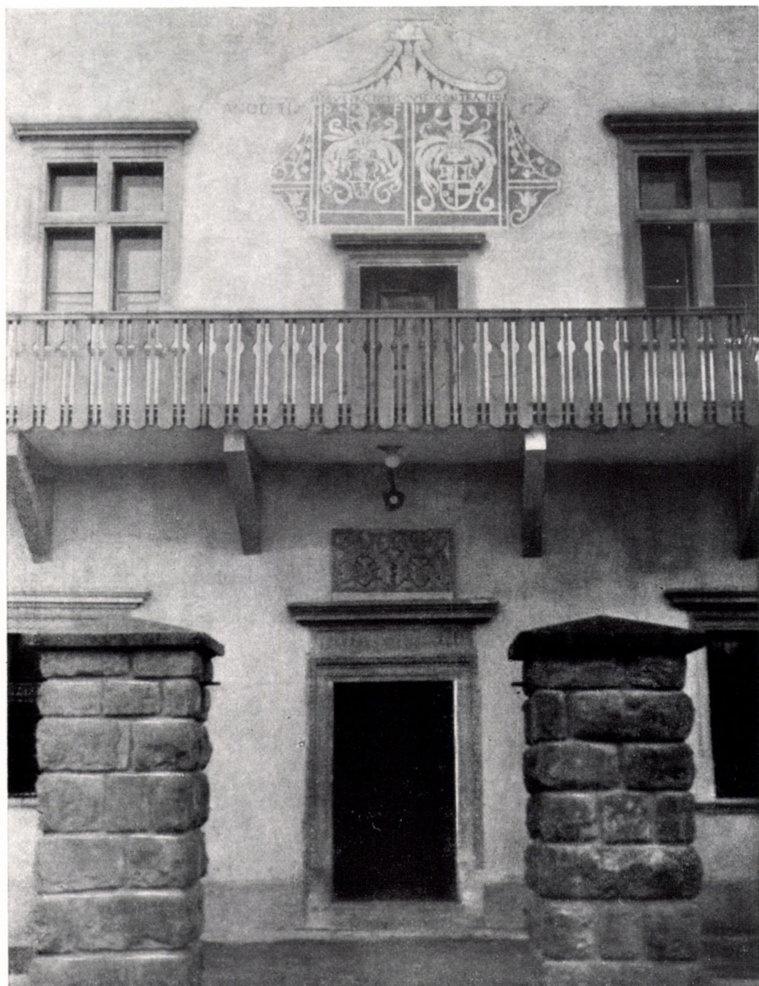
27. Bethlenfalva — Betlanovce. Homlokzatrészlet a rekonstrukció után, 1568-as felirattal
