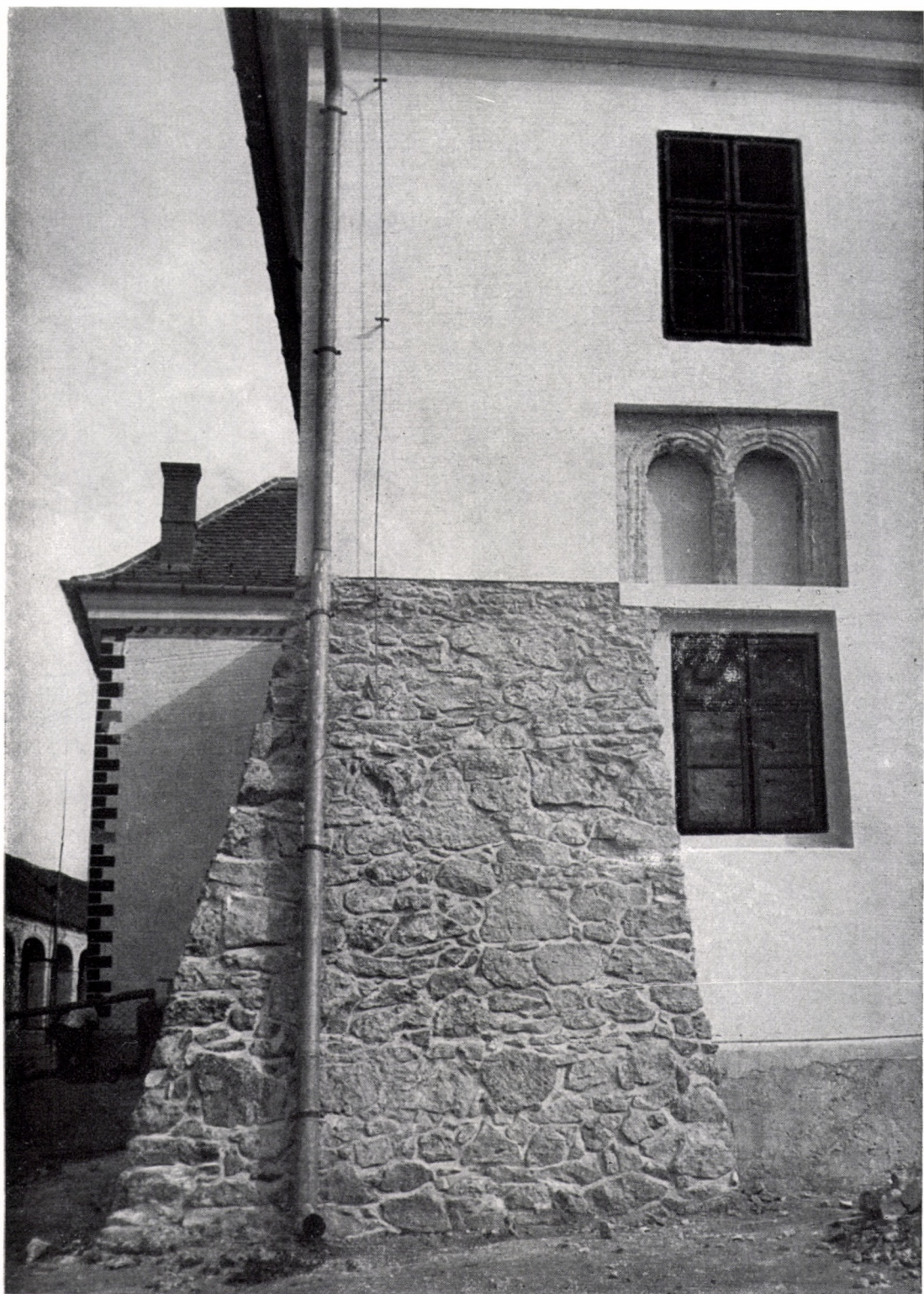
134. Monok. Az északkeleti homlokzat a helyreállítás után
