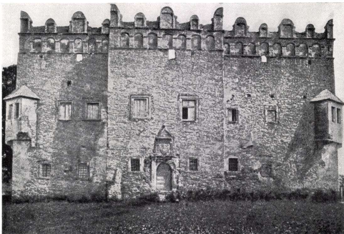
67. Frigyesvágás — Frydman. A kastély homlokzata az egykori, 1918-ban lerombolt pártázzattal és faragott díszekkel
