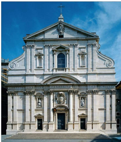
5. kép: Il Gesù, homlokzat, 1575
