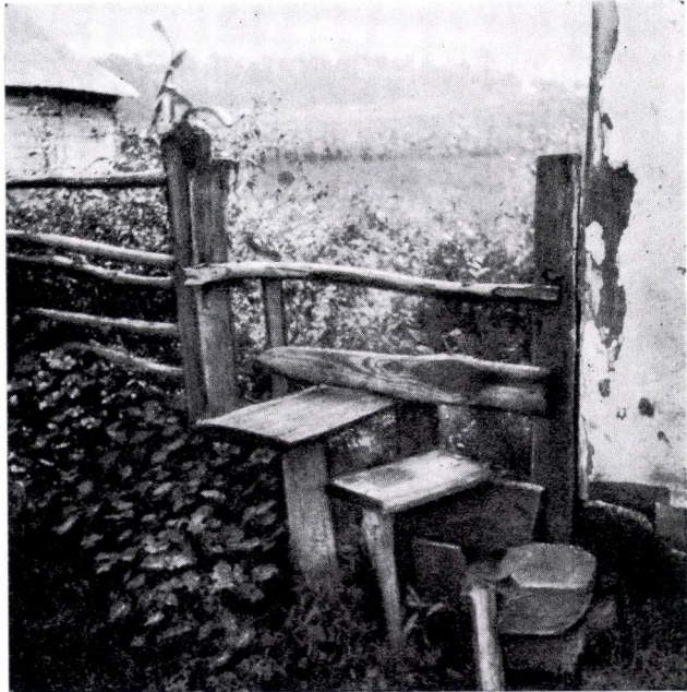
184. kép. Hágó a szomszédos telkeket elválasztó kerítésen (m.). Domokos, Lápos völgye. Románia. Gunda B. felv.
