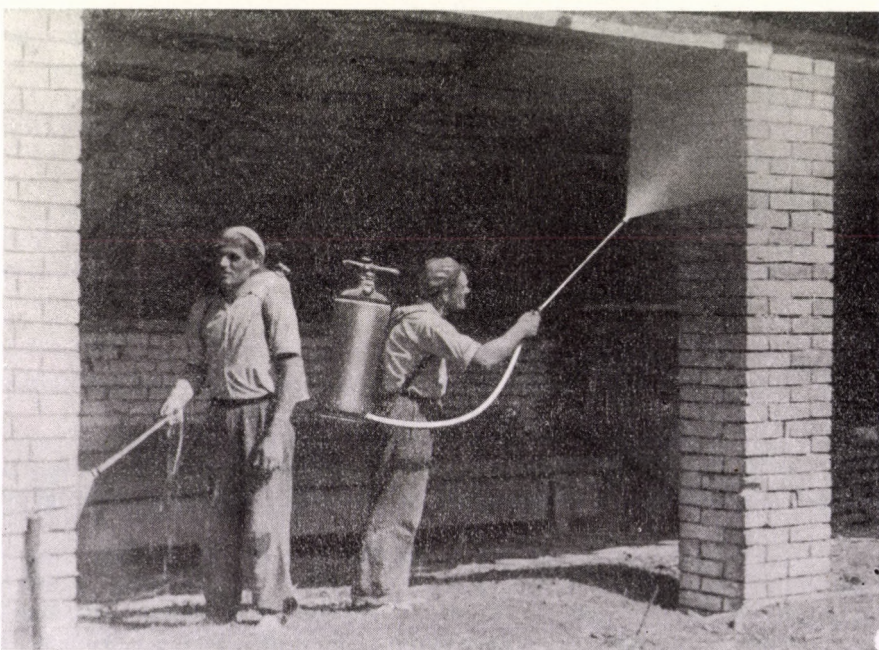
36. ábra. Házak tartós szúnyogmentesítését nagynyomású háti permetezőgéppel végezhetjük (ZOLTAI felvétele)
