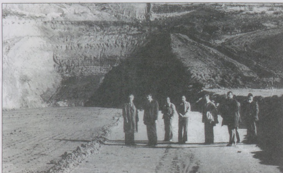
10. ábra. A duhoki völgyzáró gát építés közben
