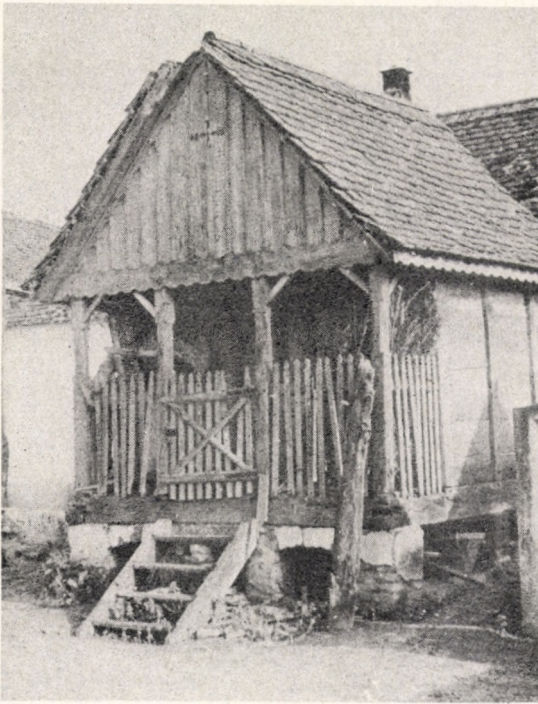
84. Tornácos gabonás. Kásád
