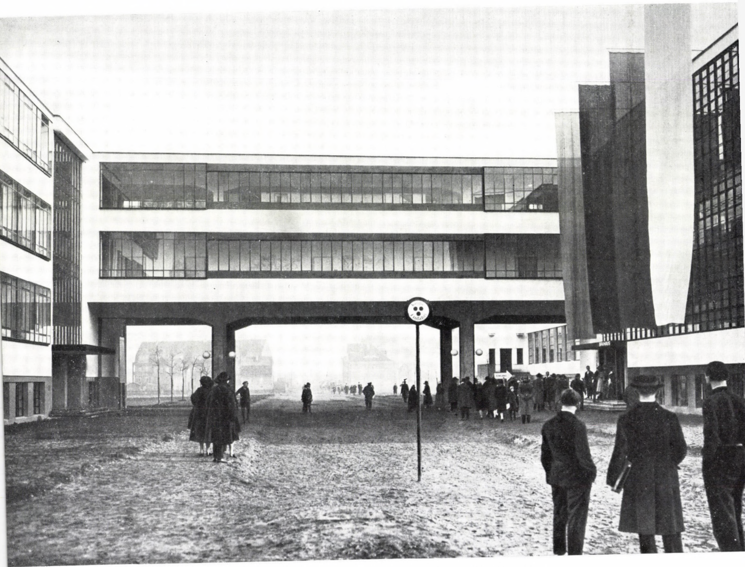
9 Bauhausgebäude. Über die Straße geführter Verbindungstrakt — Verwaltung und Architekturbüro
