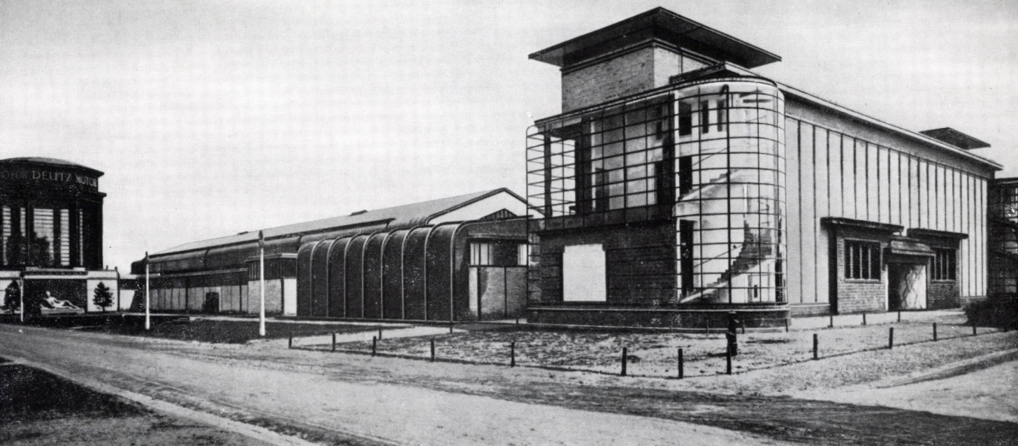
3 Beispielhafte Fabrikanlage auf der Kölner Werkbundaussstellung (1914). Mitarbeit: A. Meyer — Bürogebäude und Produktionshalle
