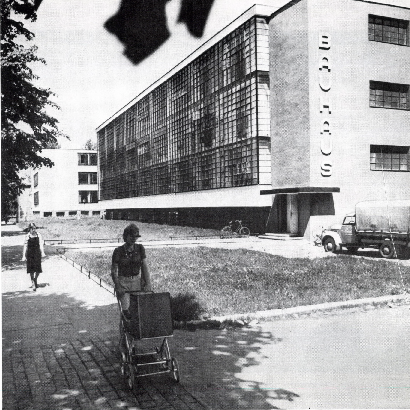
10 Bauhausgebäude — umfassende Wiederherstellung (1976)
