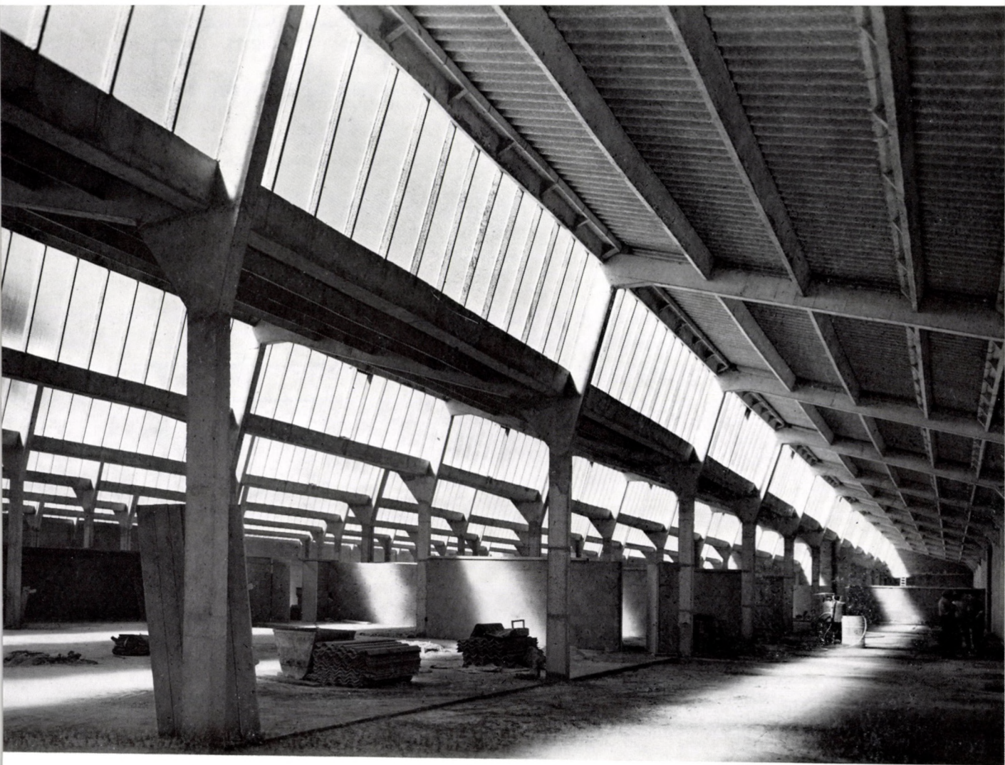
26. Építőipari szakiskola műhelyépületei. Marseille—Malpassé (1955 körül) — Belső
