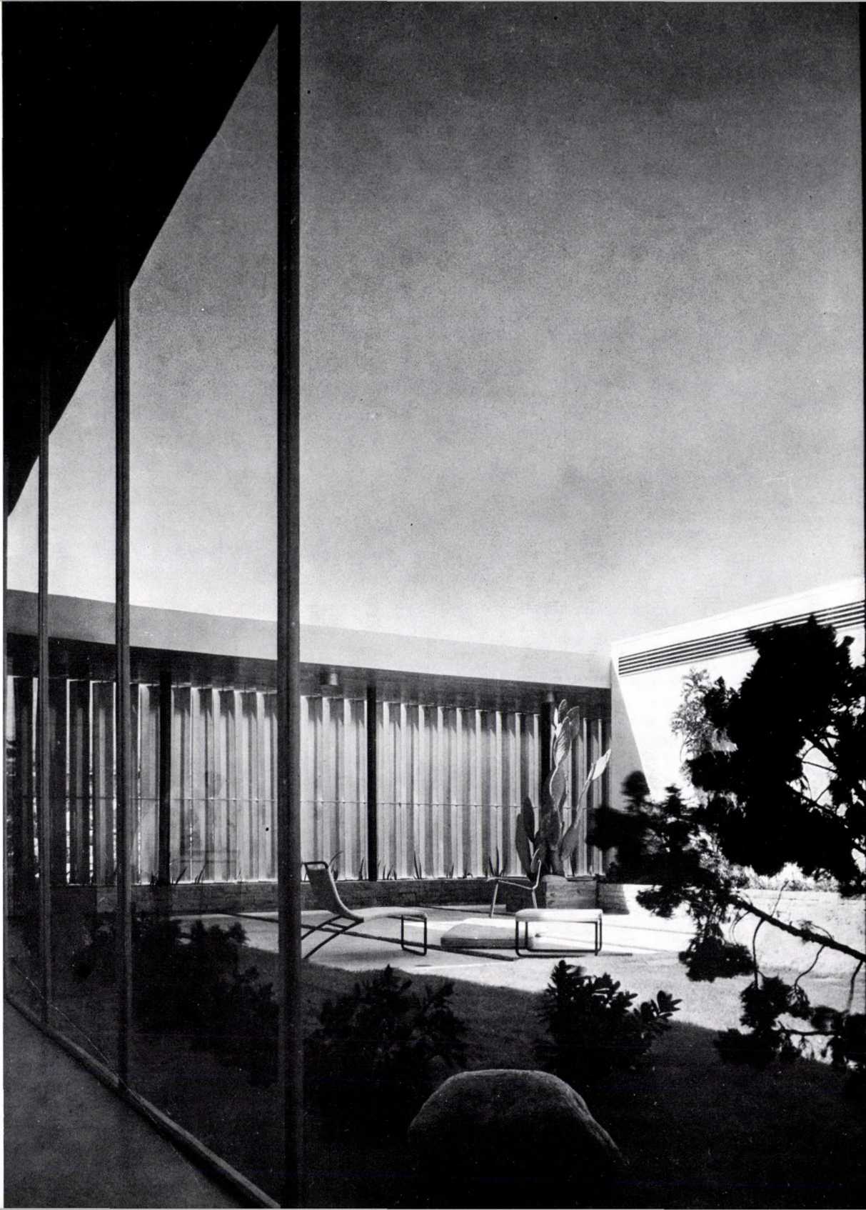
45. Hall of Records. Tetőfelépítmény és terasz
