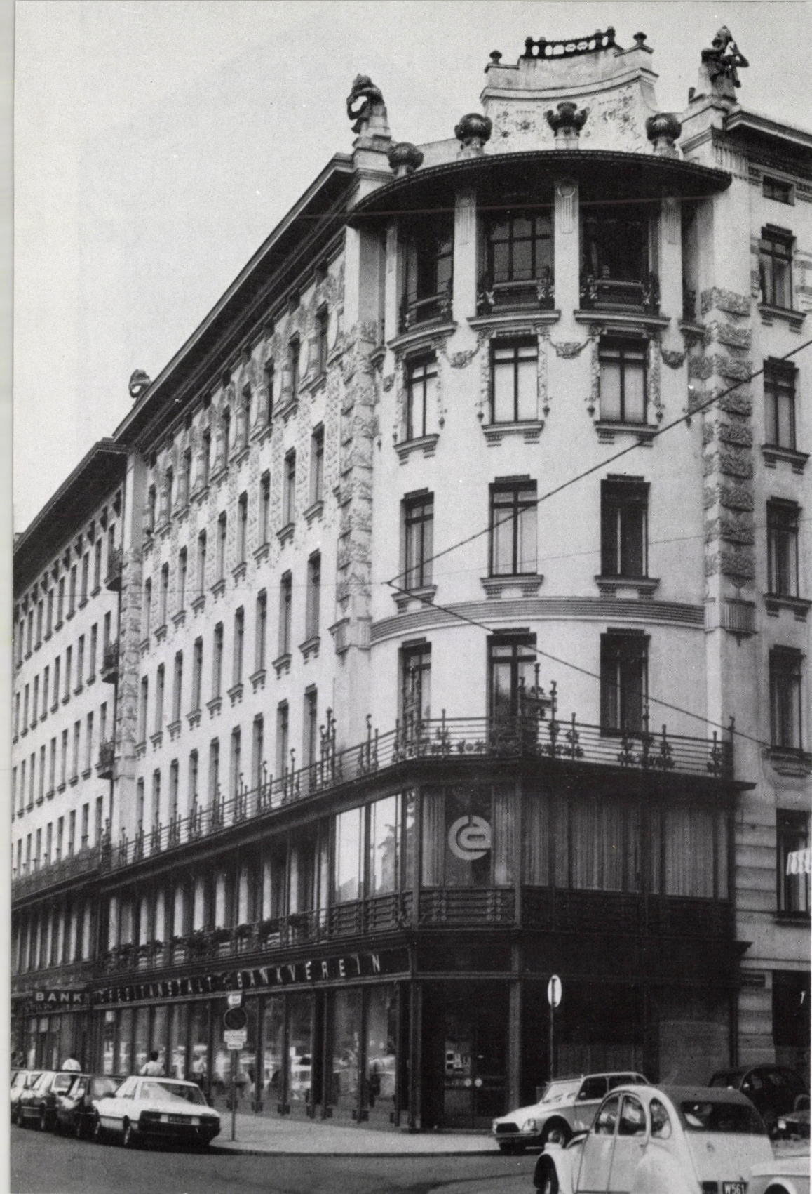
8. A Linke Wienzeile 38. sz. bérház. A saroképület teljes látkepe, balra a Wienzeile 40. sz. ház látható
