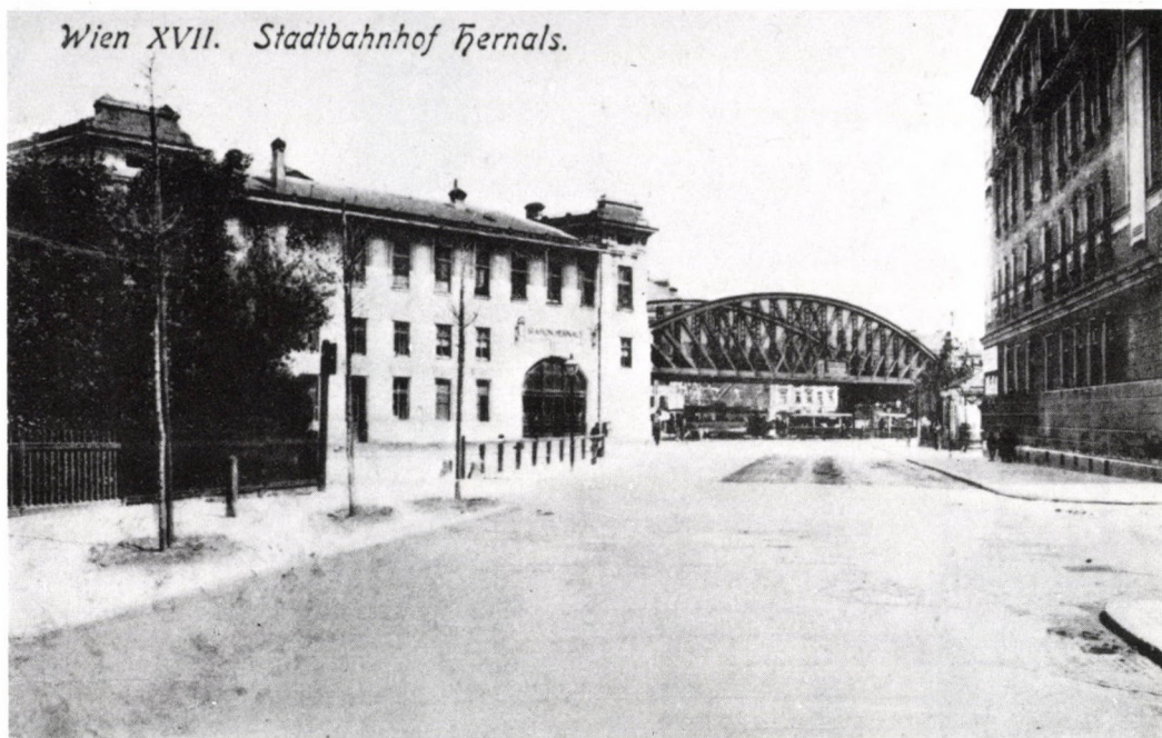
43. A városi vasút. Elővárosi vonalszakasz. Hernals-állomás, 1896. (Korabeli felvétel)
