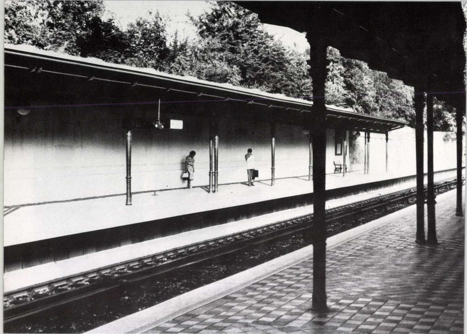
37. A városi vasút. Schönbrunn-megállóhely. A mély vezetésű vonal peronjai a támfalakhoz illeszkedő tetőkkel
