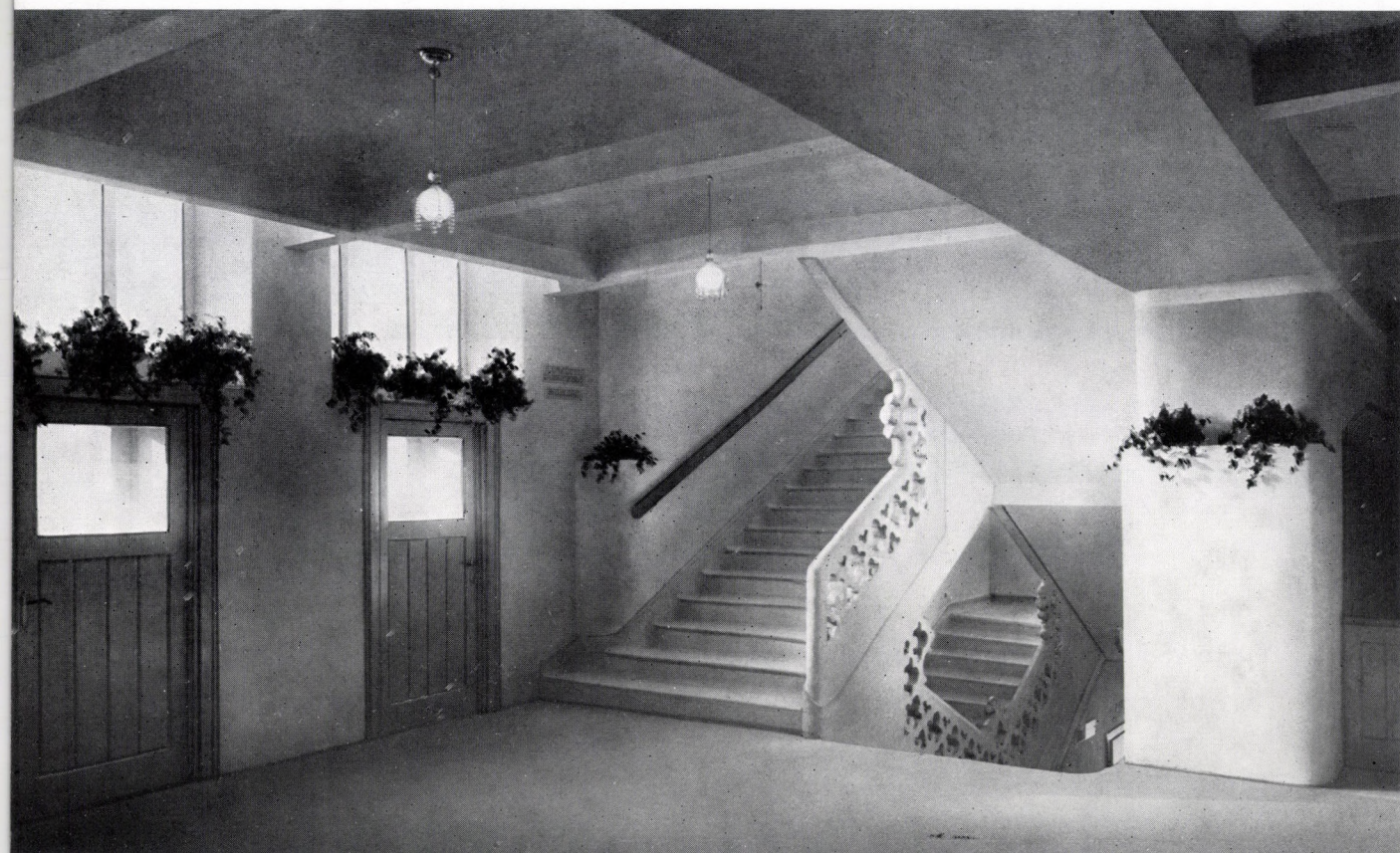
19. Sopron. Színház. Az emeleti lépcsők (1908—09)
