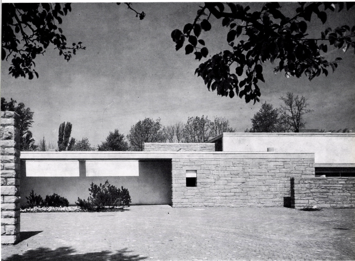
52. A Staehelin-ház. Feldmeilen. Svájc (1957–1958) Munkatársak: Herbert Beckhard, Eberhard Eidenbenz. Svájc
